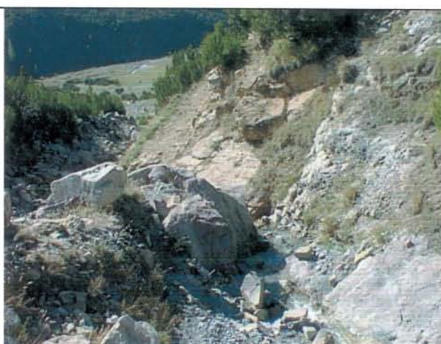
Foto 6 Alveo ben incassato al termine della curva a destra
