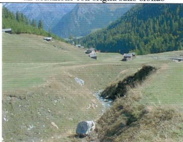
Foto 27 Tratto d'alveo a valle della briglia
