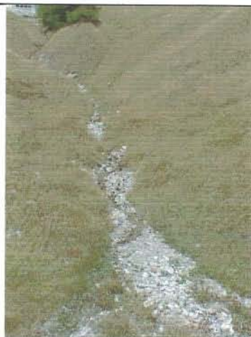
Foto 3 Tratto d'alveo a monte della prima briglia a monte della strada della Val Federia
