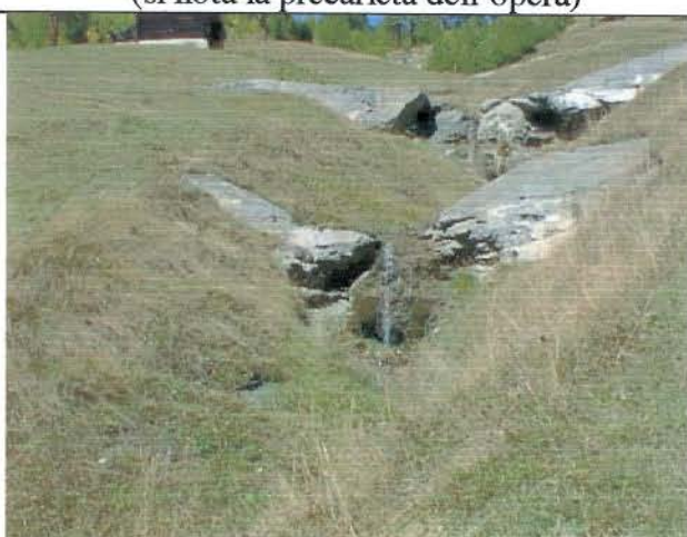
Foto 14 Seconda briglia nel tratto costeggiato da prati (si nota la precarietà dell'opera)
