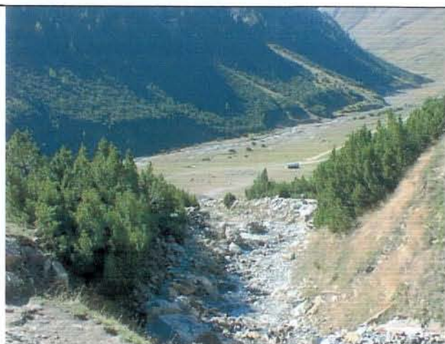
Foto 7 Vista verso valle
