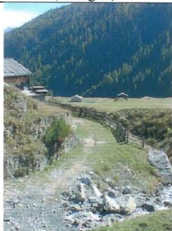
Foto 24 Attraversamento di accesso ad un'abitazione con guado
