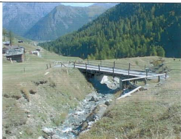
Foto 28 Ponte sulla strada della Val Federia (vista da monte)
