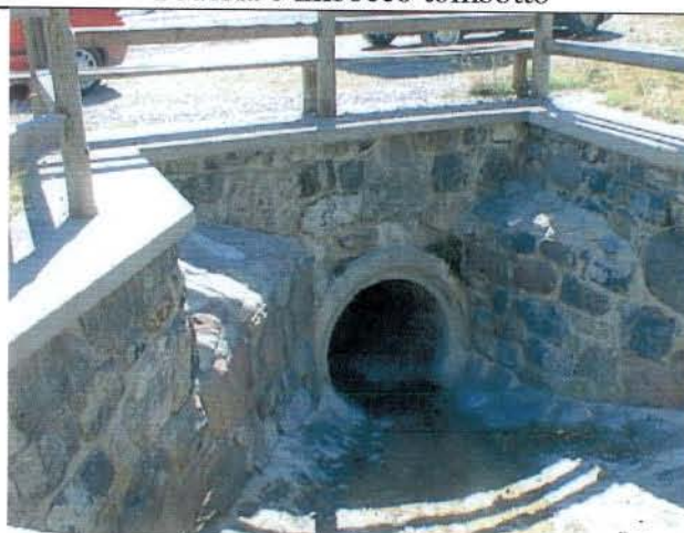
Foto 6 Imbocco tombotto di attraversamento della strada della Val Federia
