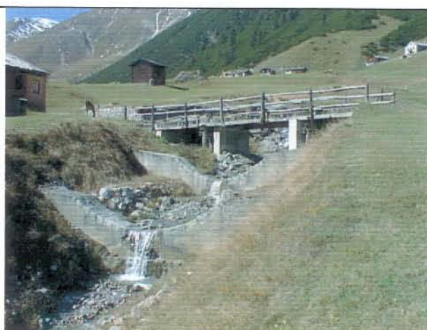
Foto 29 Ponte sulla strada della Val Federia (vista da valle con briglie)
