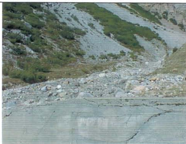
Foto 22 Briglie poste al termine del tratto incassato (dettaglio)
