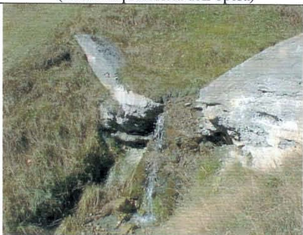
Foto 13 Seconda briglia nel tratto costeggiato da prati (si nota la precarietà dell'opera)
