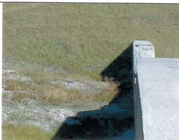
Foto 2 Prima briglia a monte della strada della Val Federia (particolare)
