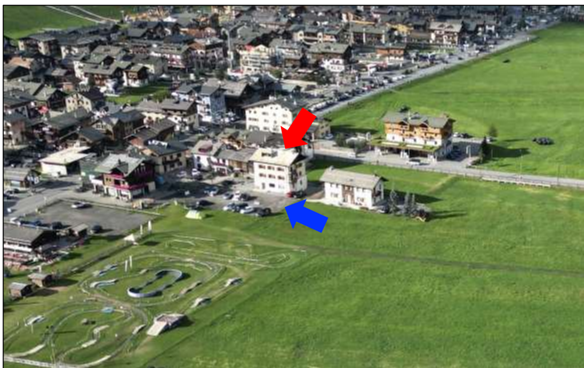
Figura n° 3 - Vista aerea da via Bondi della zona oggetto di studio con indicazione del fabbricato oggetto di intervento (freccia rossa) e delle aree esterne (freccia blu)
