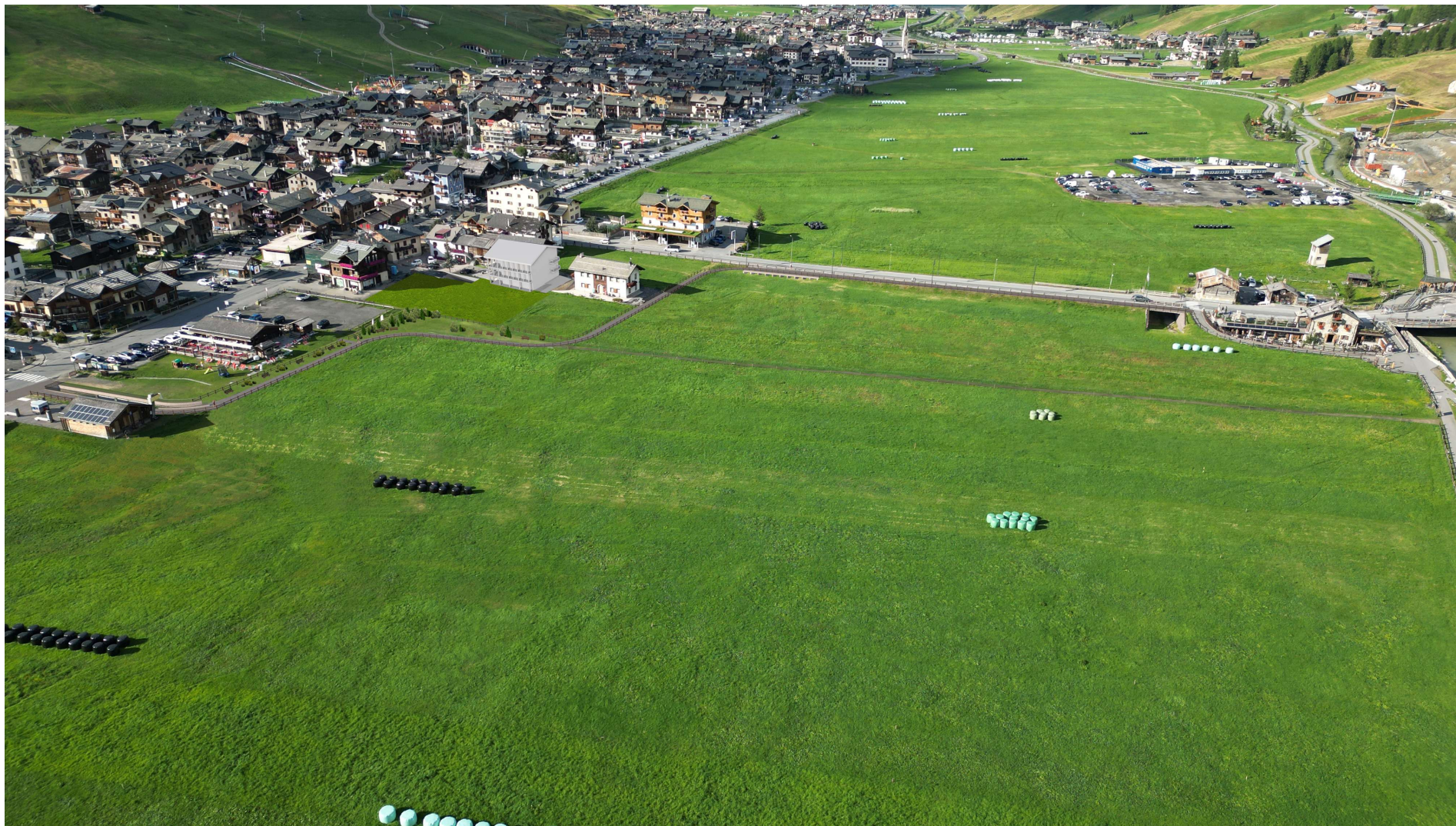
Inserimento 1 – vista aerea da sud dell’area oggetto d’intervento – edificio e pista ciclopedonale (la pista è oggetto di previsione urbanistica e non fa parte del presente P.I.I.)
