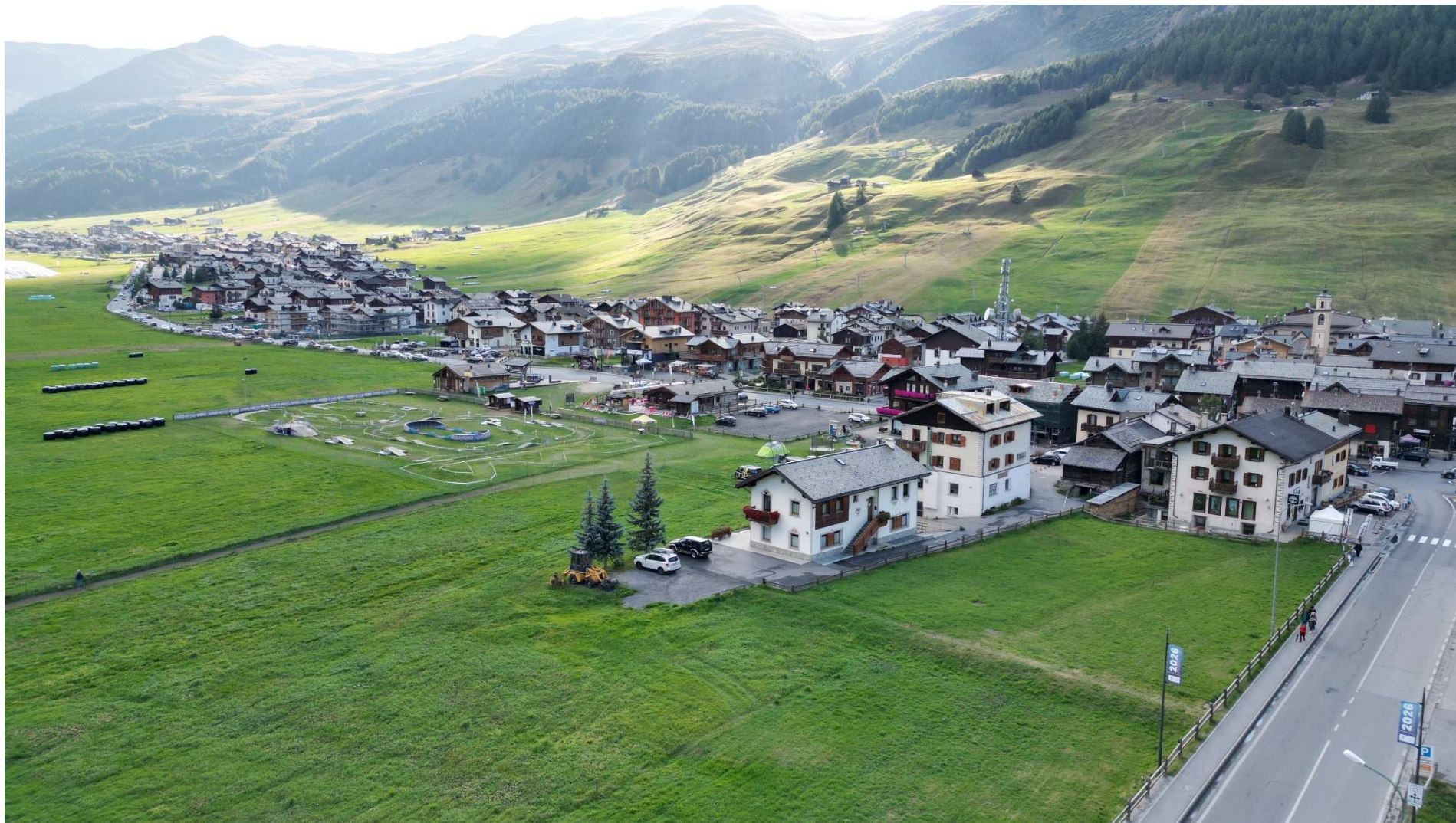
Foto 2 – vista aerea da nord dell'area oggetto d'intervento
